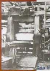
Achenbachtrio zum Plattieren und Walzen von Stahl
