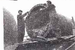
Reinigung der Gasleitung
