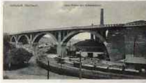
Neue Brücke am Schmalgrund
